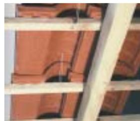
Fixation des tuiles en plain carré pour tenue au vent par pannetonnage.
