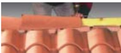
Pose des clips pour fixation des faîtières pureau variable sur lisse de rehausse.
