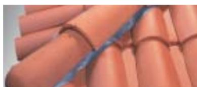
Arêtiers et bouts d'arêtier pureau variable à emboîtement posés à sec, sur closoir ventilé, sans emploi de mortier.
