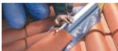
Après coupe des tuiles d'approche, pose du closoir ventilé sur lisse de rehausse et fixation des arêtiers par clips.
