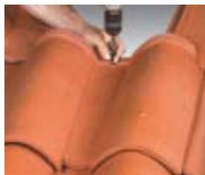
Fixation des tuiles double bourrelet en rive latérale droite par vis et rondelle d'étanchéité.
