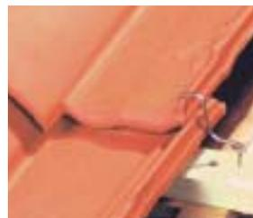
Fixation des tuiles en plain carré pour tenue au vent et à la pente par crochet "V2" réf. CRV02.
