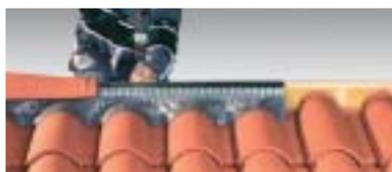
Après mise en place du closoir ventilé, les faîtières sont fixées par crochet adapté au modèle, vissé dans la lisse de rehausse.
