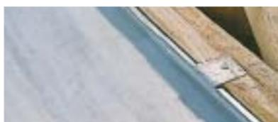
Mise en place de la noue métal façonnée à relevés, contre liteau filant et patte de fixation.
