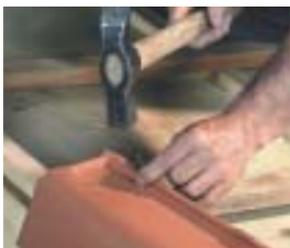
Fixation des rives rondes individuelles à emboîtement en rive latérale gauche et droite par clou.
